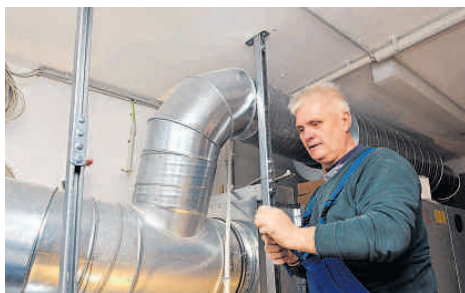
Die Firma Stahl- und Heizungsbau Weissenfels arbeitete fast ein ganzes Jahr in der Berufsschule. Klaus Nowak montiert ein Lüftungsgesät.
